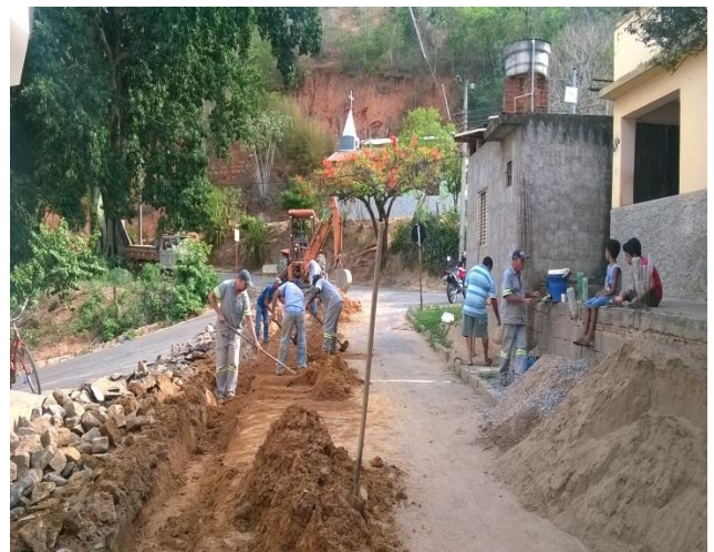
Ampliação de rede
