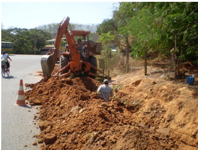
Troca de tubulação na Av. Aimorés
